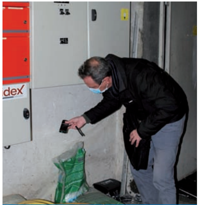
Diagnostic de vulnérabilité d'une école - Janvier 2021
