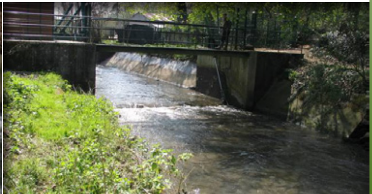
Le même clapet abaisse depuis mars 2010
