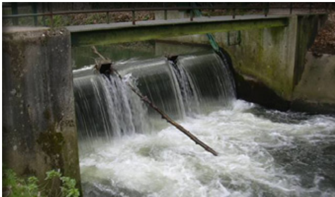
Le clapet de Souchard avant abaissement
