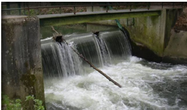
Le clapet de Souchard avant abaissement
